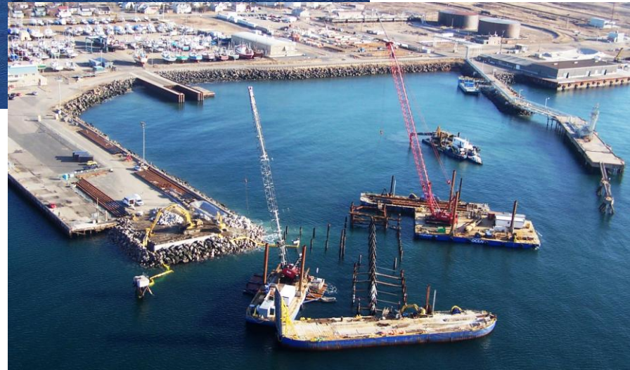
Wharf construction in Sept-Iles
